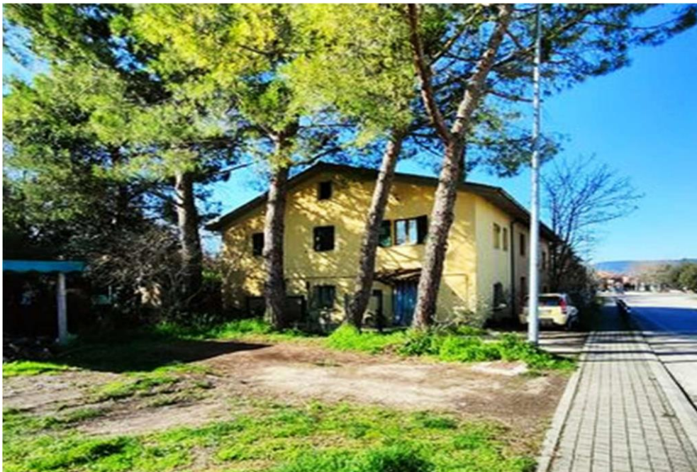
Foto 1- Vista della Porzione del Fabbricato (Mapp.13)
