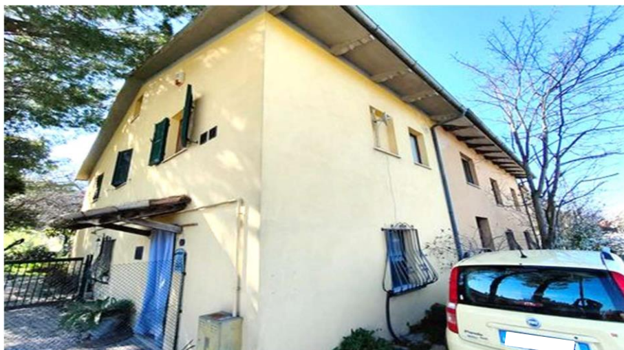
Foto 2- Vista della Porzione del Fabbricato (Mapp.13)
