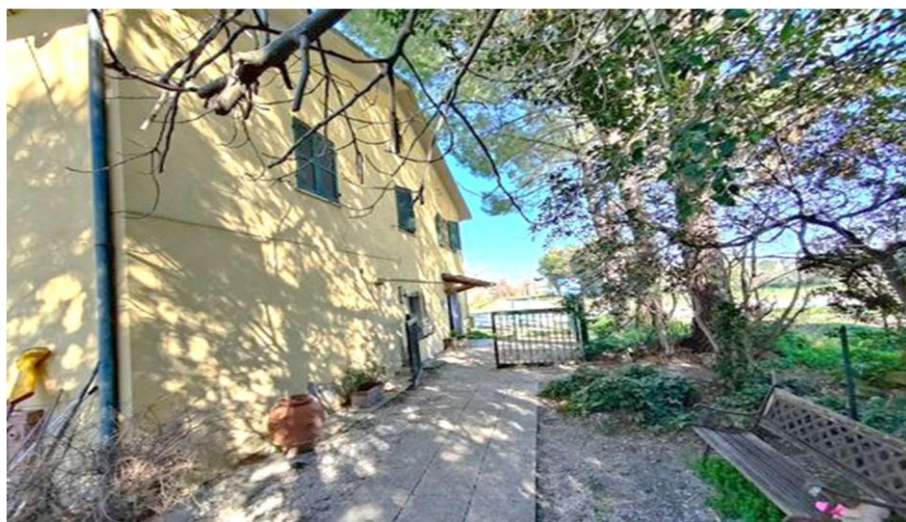
Foto 3- Vista della Porzione del Fabbricato (Mapp.13)
